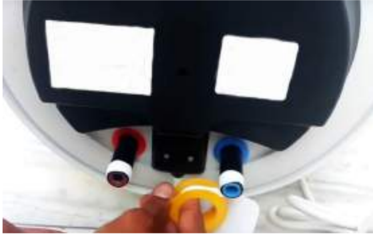
चित्र 3.162 इनलेट और आउटलेट के कनेक्शन पर टेफ्लॉन टेप लगाएं
