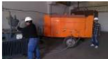
चित्र 5.20 तेल भरने की मशीन का उपयोग करके ट्रांसफार्मर में तेल भरना
