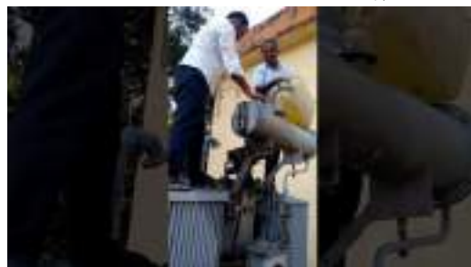
चित्र 5.21 ट्रांसफार्मर में मैनुअल तरीके से तेल भरना
