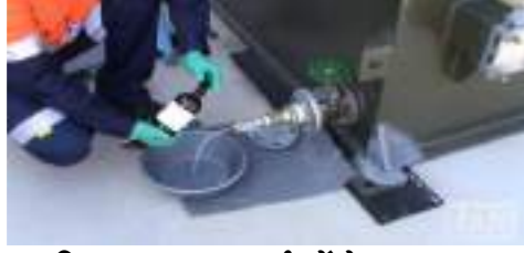
चित्र 5.22 ट्रांसफार्मर में तेल बदलना
