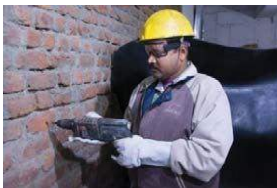
चित्र. 5.1 : पावर ड्रिल मशीन का उपयोग करना
