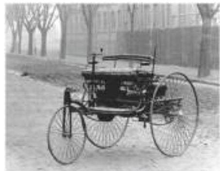
चित्र 1.8: मूल बेंज पेटेंट-मोटरवैगन की तस्वीर, पहली बार 1885 में निर्मित
