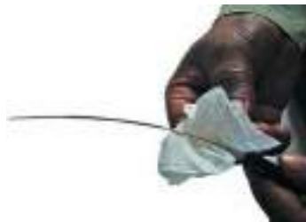
चित्र 5.15: टिश्यू पेपर के साथ फाइबर के गुच्छे के चारों ओर जेली को हटाना
