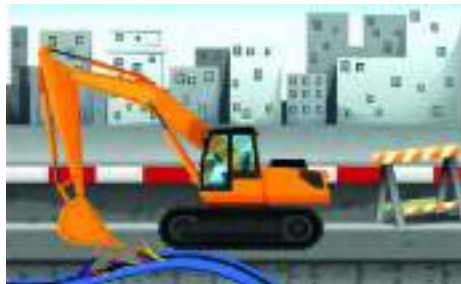
चित्र 5.5: निर्माण के कारण फाइबर केबल को क्षति
